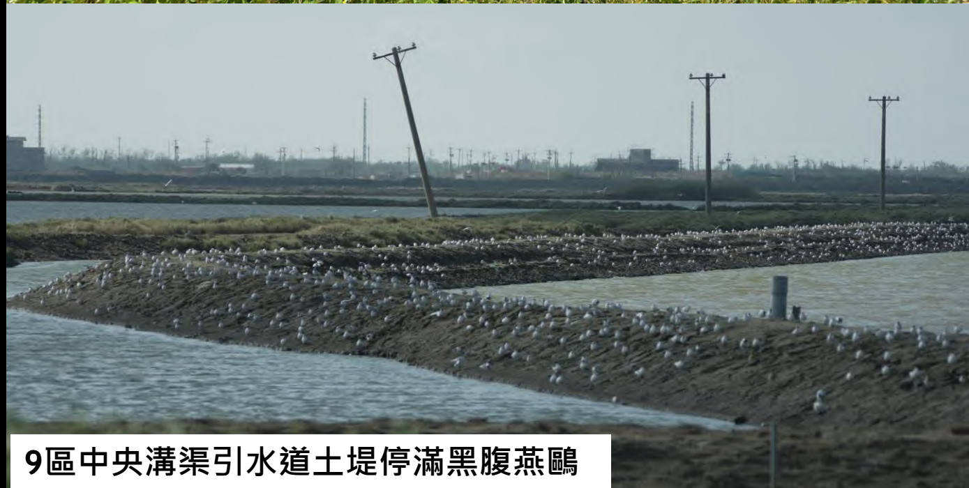
9區中央溝渠疏濬完成築堤作業
