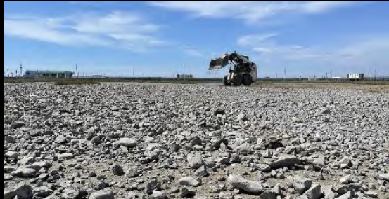
韋能能源水中島改善 鋪設碎石增加透水性
